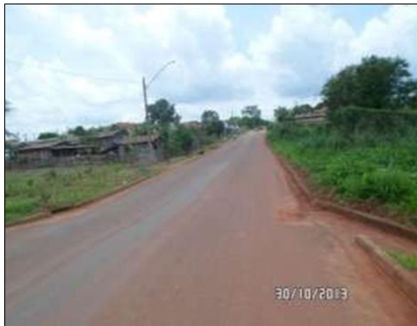
Figura 72 - Via pavimentada com presença de dispositivo de microdrenagem Fonte: E.C.P. Soluções (2014).
