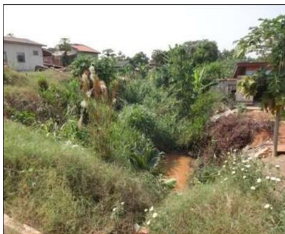
Figura 69 - Canal de macrodrenagem natural Fonte: E.C.P. Soluções (2014).
