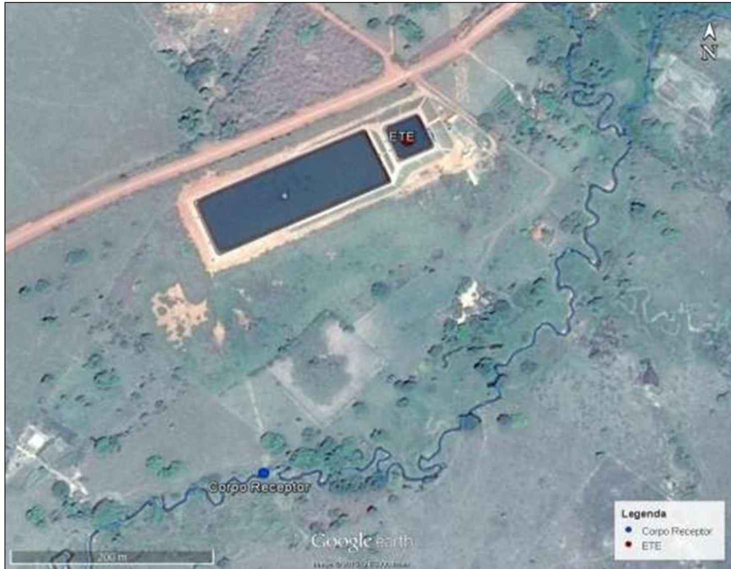
Figura 62 - Localização do corpo receptor de efluente tratado na ETE
